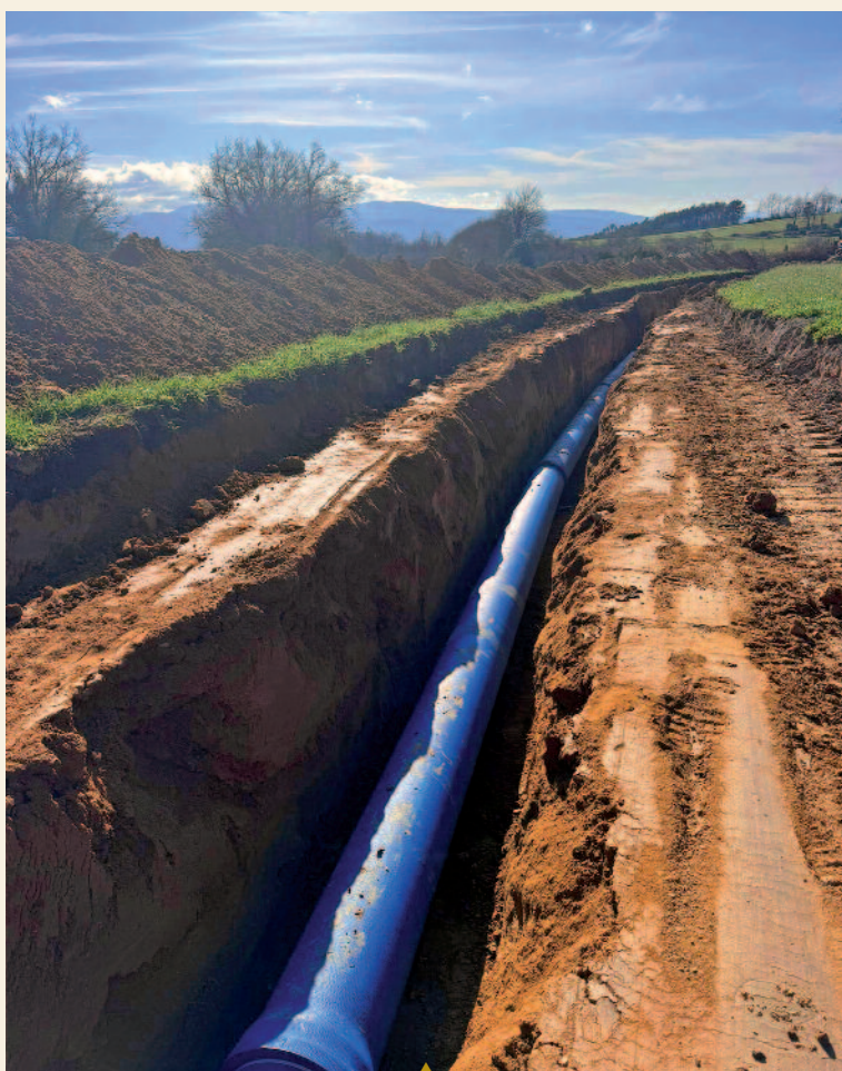
Travaux de modernisation du réseau d'eau potable du SMAEP du Pas des Bêtes
