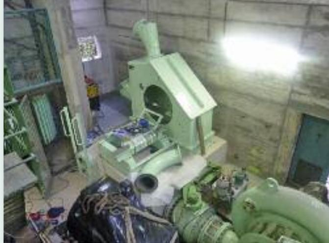
► **Novembre** : vers le 15 de ce mois, remise en eau de la conduite forcée, remise en service de l'ancienne turbine, contrôle et validation des paramètres mécaniques et électriques de la nouvelle turbine.
